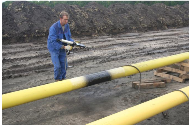
Рисунок 5. Картриджная (б) технология изоляции сварных стыков в трассовых условиях при предварительной (а) очистке и подготовке поверхности щёточными устройствами MONTI Bristle Blaster.
