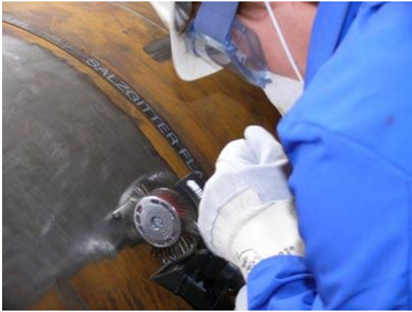
Рисунок 5. Картриджная (б) технология изоляции сварных стыков в трассовых условиях при предварительной (а) очистке и подготовке поверхности щёточными устройствами MONTI Bristle Blaster.
